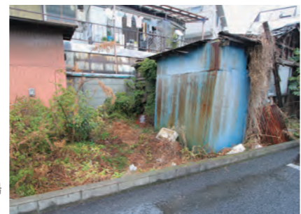
●なんと新しく建てられた工場の真裏には廃屋寸前の建物が!
