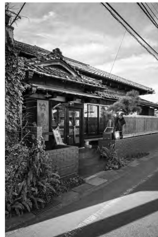
●建物は木造平屋建て。櫻井さんが屋根裏に上って構造を見たところ「釘が使われていない昔ながらの日本家屋のつくりだった」という
