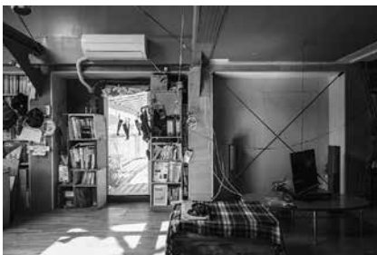
上●3階の個室には2階を見下ろす室内窓を設けている。現在は長男夫妻の次男がこの部屋を使っている。M1の鉄骨梁の上の波状の部分は、既存のM1の屋根に使われていた波板の痕跡 左●現在も耐震補強のための工事が進んでいる。最新の耐震基準に合わせて構造計算をし直し、壁にプレースを入れて補強することになった。2階はこのプレースを現しにする予定だ
