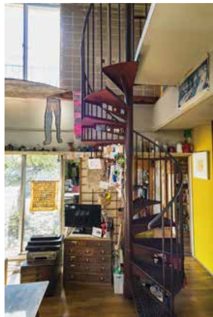
左●母親が生前使っていたスペース。天井には花柄の壁紙。現在はのり子さんの研究室として活用 上●のり子さんのスペースに設置された鉄製の螺旋階段。M1を上下に2個重ね、天井を抜いてつくった吹き抜けをつなぐ
