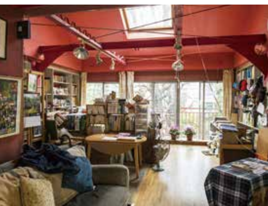
●林・富田夫妻のリビング。奥につながるワークスペースは、天井を抜いて吹き抜けに。M1の構造体を現しにしている。南側の屋根にトップライトを設け、採光性も高めている
