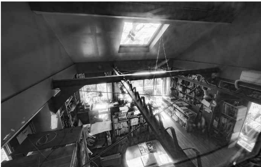
上●3階の個室には2階を見下ろす室内窓を設けている。現在は長男夫妻の次男がこの部屋を使っている。M1の鉄骨梁の上の波状の部分は、既存のM1の屋根に使われていた波板の痕跡 左●現在も耐震補強のための工事が進んでいる。最新の耐震基準に合わせて構造計算をし直し、壁にプレースを入れて補強することになった。2階はこのプレースを現しにする予定だ
