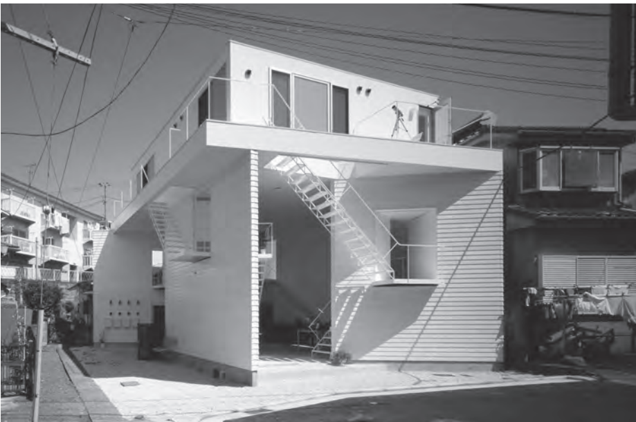
上●天井が5mもある「広場」には、キッチンなども完備。町と地続きで常にかいている。4辺を支える三角形の柱には鍵付きの倉庫を設け、家具などを収納。出しっぱなしの家具などもあるが、一度も盗難にあったり壊されたりしたことはない 右●密集した住宅街に位置する「ヨコハマ・アパートメント」。各住戸へのアクセスは「広場」からそれぞれ専用の階段が設けられている。階段は折り返し階段で、「広場」から外へ伸び、町の風景を眺めながら、各住戸へとつながる動線を形成（photo：鳥村鋼一、2点共）
