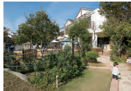
●「大きなお家」がコンセプトの頌栄保育園。広々とした園庭には緑が溢れる。手前左手が、まだ骨組みが目立つレンギョウのトンネル
