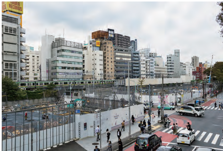
●宮下公園の改修工事。その下は店舗、ホテル、駐車場などの複合施設となり、共に2019年のオープンを目指す
