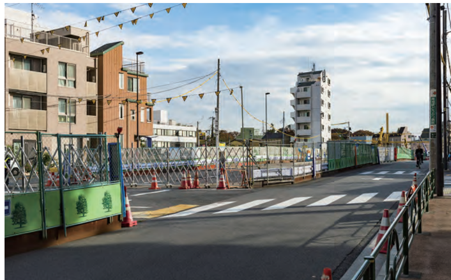
●区庁舎東側の通りでは、現在、東京都市計画道路幹線街路環状5の1号線が地下トンネル道路として整備されつつある
