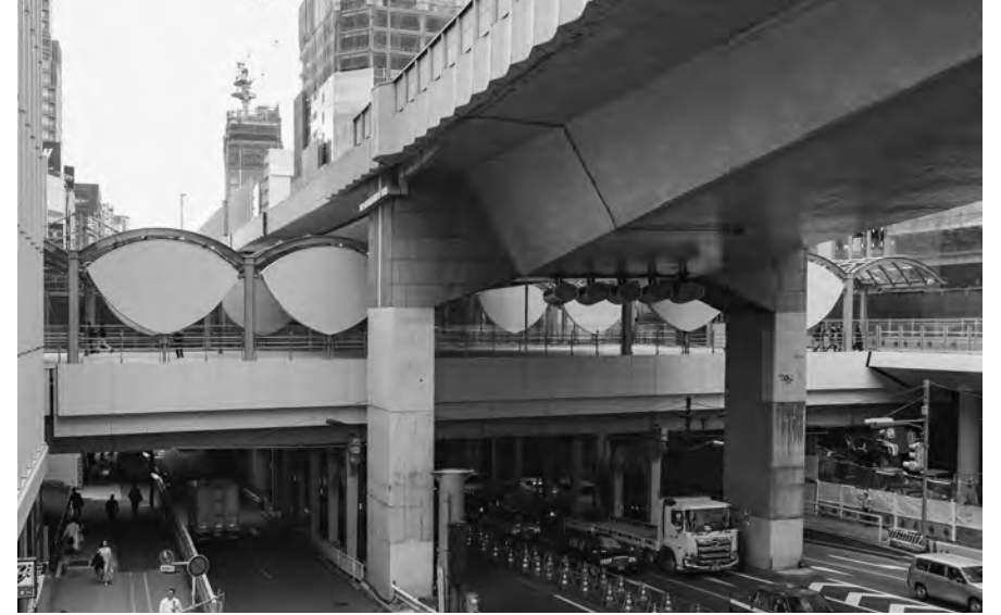
●国道246号線と上を走る首都高速3号渋谷線の間をぬって、渋谷駅と「渋谷ストリーム」をつなぐ歩行者デッキ。旧東横線の「かまぼこ屋根」のデザインが再現されている
