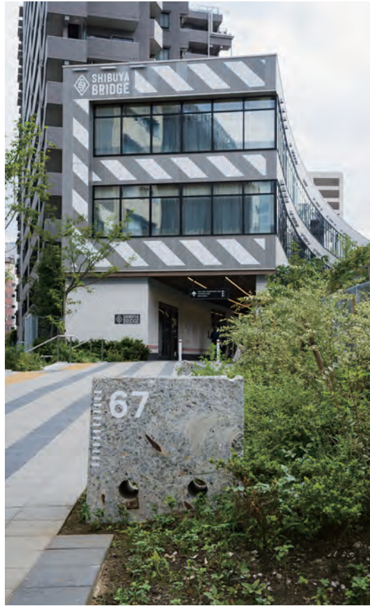
●建物の中へと遊歩道が続く「渋谷ブリッジ」。「R160（半径160m）」と呼ばれた大きなカーブに沿って建てられたビルには、認定こども園、ホテル、飲食店。オフィスなどが入る
