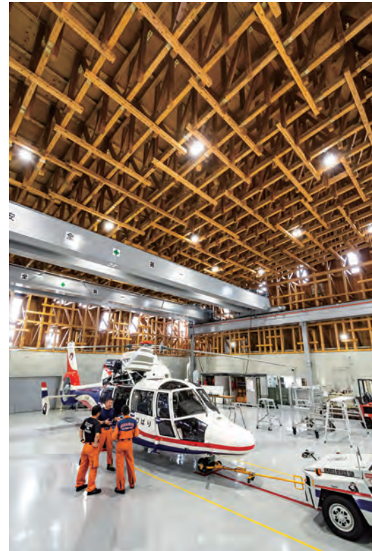
●息を呑むようなスケールで頭上に木組みが広がる、防災消防航空センター格納庫（格納庫1）の内部。天井を左右に走る鉄骨はホイスト式クレーン
