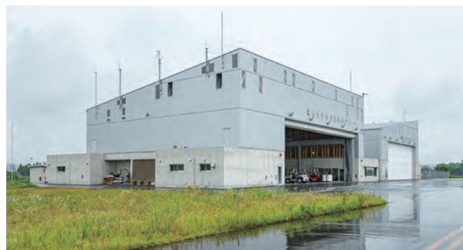
●防災消防航空センター格納庫外観。奥に見えるのが屋根の傾斜が90度異なる警察航空隊基地の格納庫（格納庫2）
