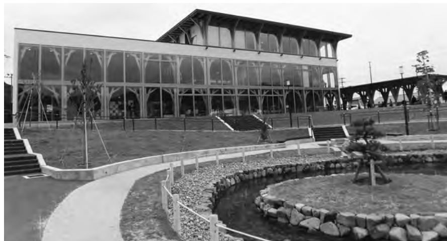
●大槌町文化交流センター「おしゃっち」。燃え代設計による1時間準耐火で3階に図書館を設けた純木造3階建て複合公共施設（設計：前田建設工業・近代建築研究所・中居敬一都市建築設計・TOC異業種特定建設共同企業体、2018年竣工）
