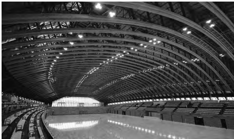
●一般サイズの大分県産製材をつなぎ、アーチトラス構造で大スパンを実現した大分県立武道スポーツセンター
