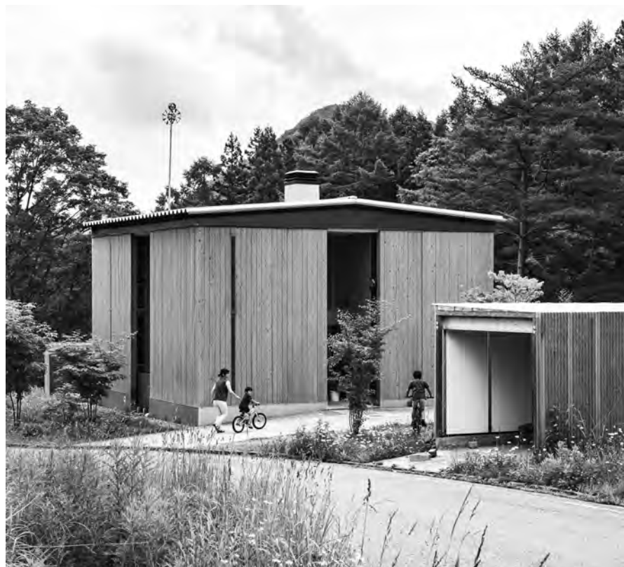
●「はりゅうの箱」（設計：はりゅうウッドスタジオ、監修：難波和彦+界工作社）。初めて縦ログ構法でつくられた住宅
