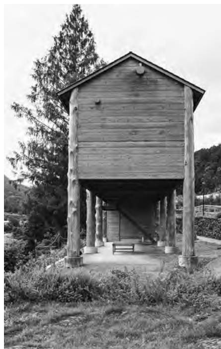
●ピロティを東側から見る。2階は浴室
