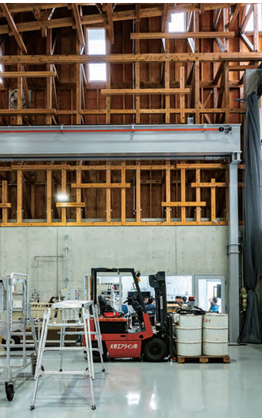
上●壁面構造のディテール。RC造の低層部に奥行き約1間の木造の耐力壁を立て、その上にトラスが架けられている
