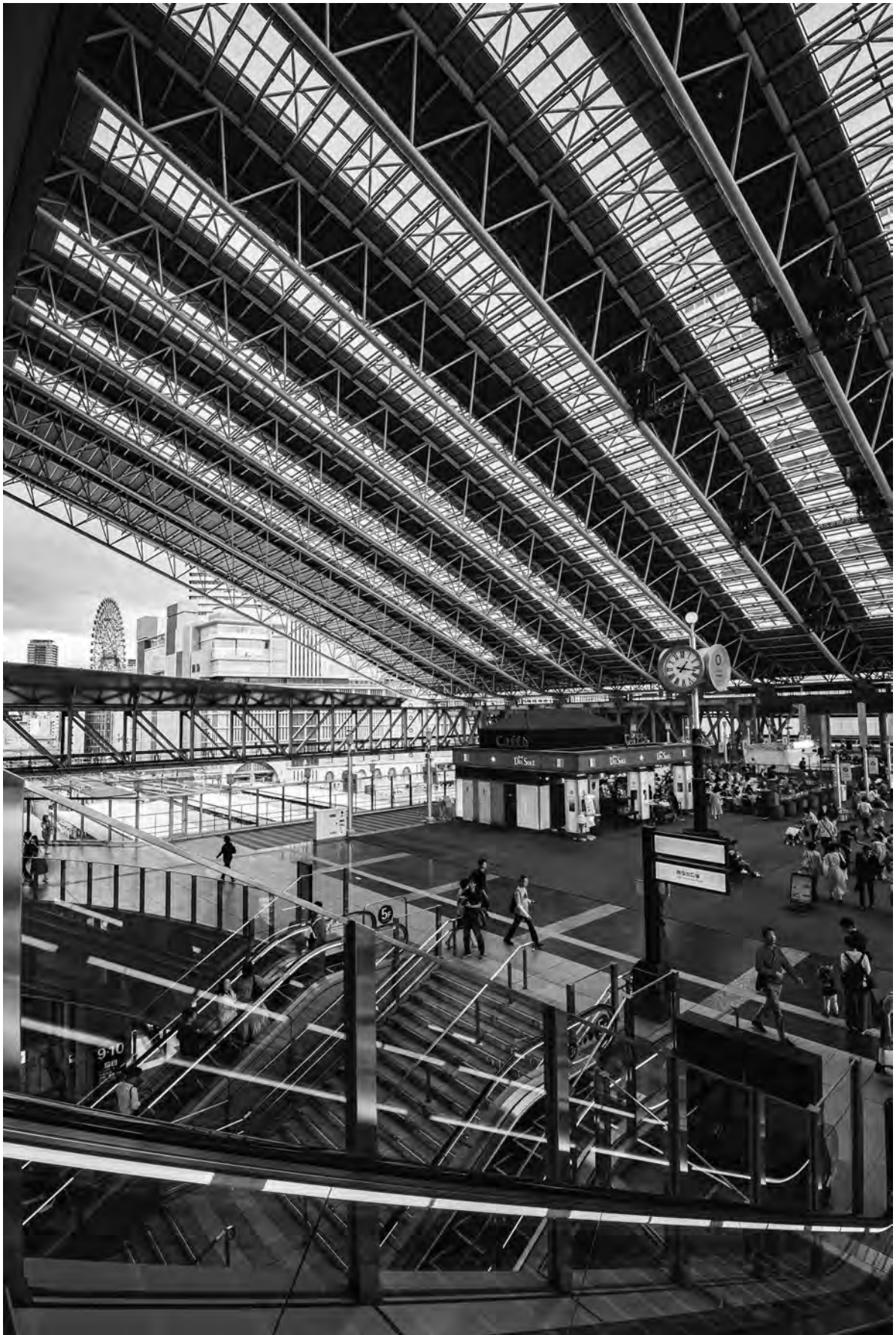
人工地盤上の駅舎を巨大なドーム屋根が覆う。大阪ステーションシティ photo:坂本政十賜
