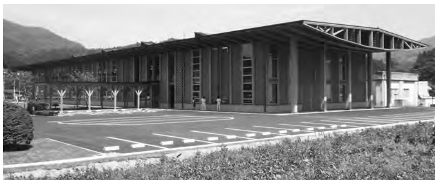
●住田町役場新庁舎。地元産のスギ材やカラマツ材を使用。格子状のラチス耐力壁を採用し、強度を確保（設計：前田建設工業・長谷川建設・中居敬一都市建築設計異業種特定建設共同企業体、2014年竣工）
