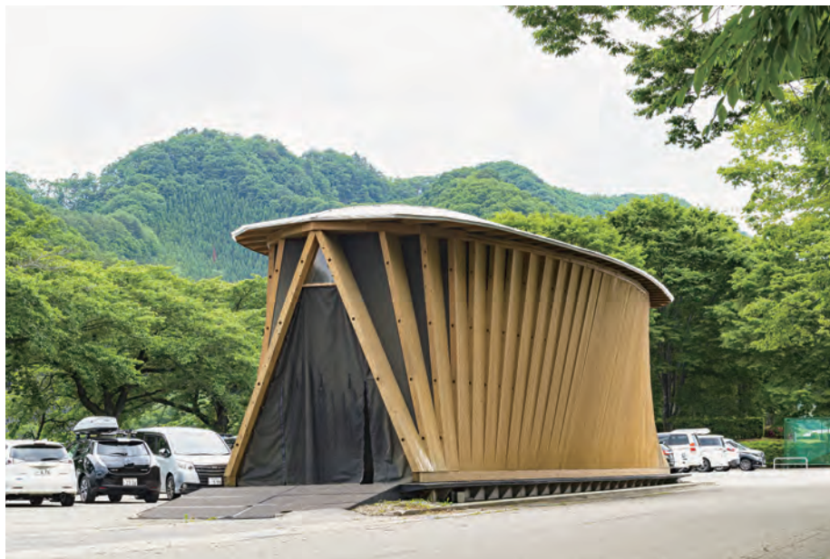
●福島県南会津郡のびわのかけ総合公園内に建つ、「びわのかけ屋内投球場」（設計：はりゅうウッドスタジオ、EDH遠藤設計室、江尻建築構造設計事務所）。180mm×120mm×4本をボルトで結束させた縦ログパネルを用いて設計された
