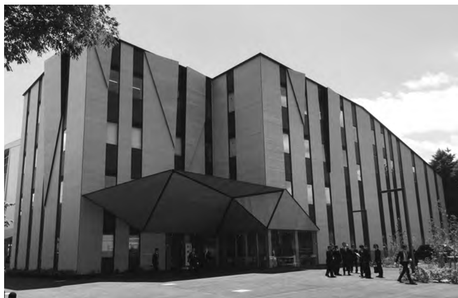
●桐朋学園仙川キャンパス新校舎。4階建ての耐火木造建築。外装には耐火認定を取得している外壁構成、難燃処理を施している(設計:前田建設工業、隈研吾建築都市設計事務所、2017年竣工)
