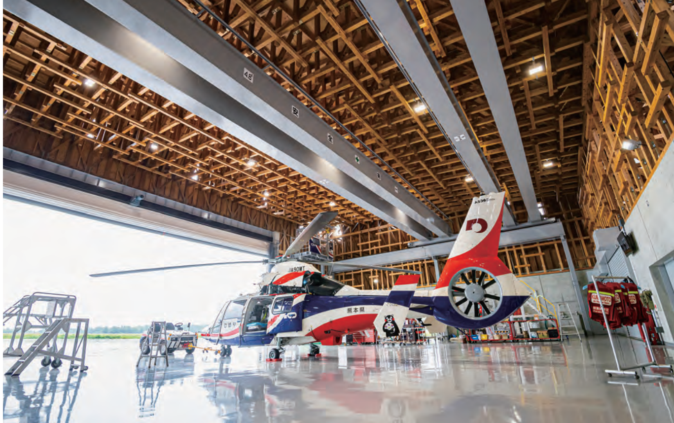
●開口部を開けた格納庫1。扉には、軽量化と開閉時間の短縮・省力化のため、日本ではまだ普及していないスウェーデン製のシートシャッターを採用している
