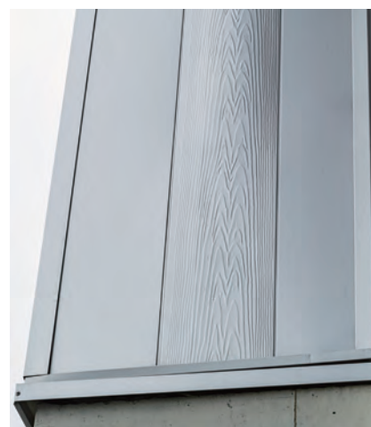
●ガルバリウム鋼板の外壁。ところどころに、小川さんが「イタズラしてみた」と笑う木目のエンボス加工が施されている
