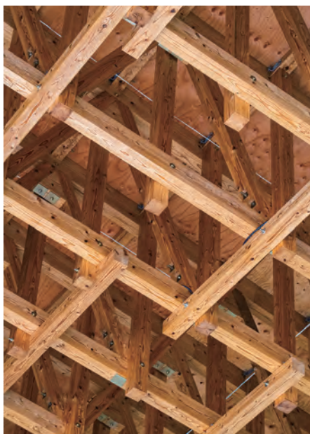
上●壁面構造のディテール。RC造の低層部に奥行き約1間の木造の耐力壁を立て、その上にトラスが架けられている
