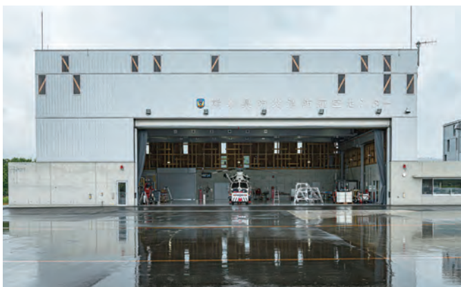
●格納庫1の外観。ガルバリウム鋼板の外壁材で一見木造らしくないが、窓には木の構造材が見える
