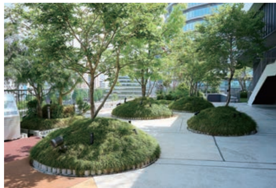
●樹木の根本をリュウノヒゲマットで覆うことで、立ち上がり部分を自然に感じさせる「くまモン盛土」
