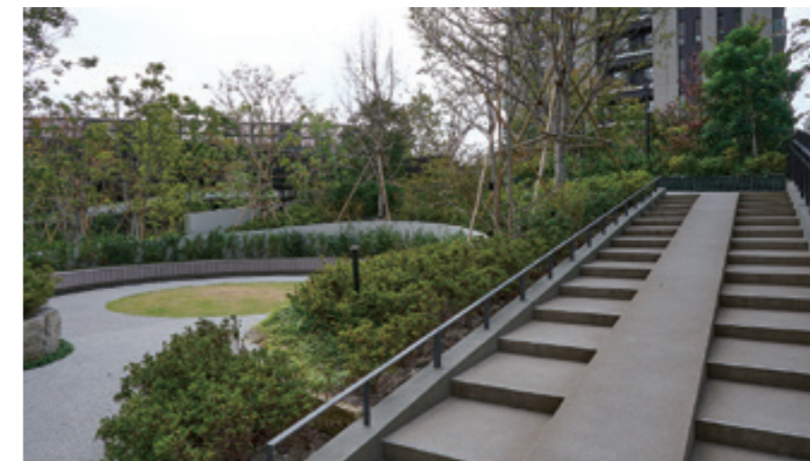
●敷地の中央部に位置する「浄水の丘」。人工地盤上に軽量土壌を用い、浄水緑地とのつながりを意識した緩やかな丘陵として整備。人工地盤の下は駐輪場となっている
