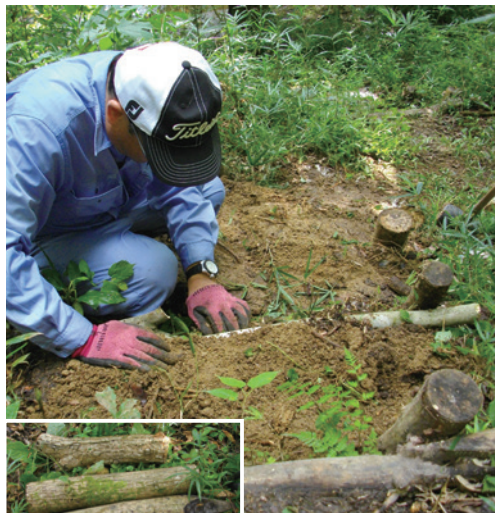
散策路の整備 間伐や倒木で出る材を土留めなどに利用している。
