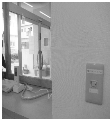
事務室に電源スイッチを設置
